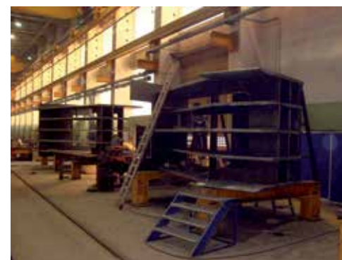
18 Vorfertigung der Doppelquerrahmen © Max Bögl Bauunternehmung GmbH & Co. KG
