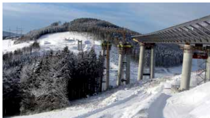
30 Stahlüberbau vor dem dritten Takt © Max Bögl Bauunternehmung GmbH & Co. KG
