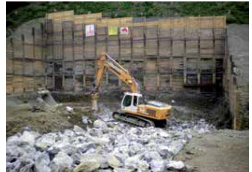
10 Aushubarbeiten für die Pfeilergründung in Achse 50 © Max Bögl Bauunternehmung GmbH & Co. KG
