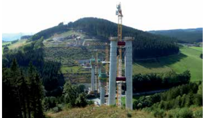
13 Herstellung der Pfeiler © Max Bögl Bauunternehmung GmbH & Co. KG
