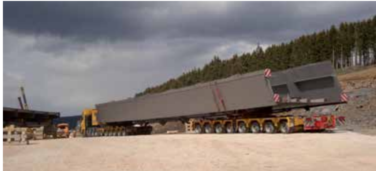
23 Lkw-Transport von Schuss 11 © Max Bögl Bauunternehmung GmbH & Co. KG
