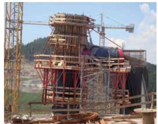
12 Kletterschalung zur Herstellung der Pfeiler © Max Bögl Bauunternehmung GmbH & Co. KG
