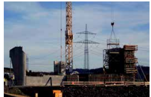
11 Herstellung des Widerlagers in Achse 80 © Max Bögl Bauunternehmung GmbH & Co. KG
