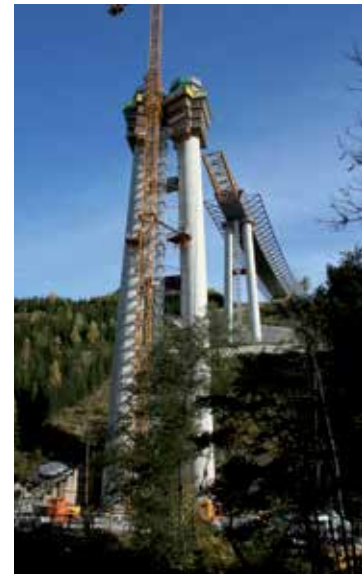
29 Auffahren am Pfeiler in Achse 60 © Landesbetrieb Straßenbau Nordrhein-Westfalen
