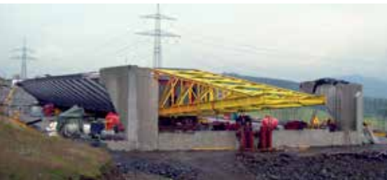
27 Vorbausechnabel vor dem ersten Verschiebung in Achse 80 © Max Bögl Bauunternehmung GmbH & Co. KG
