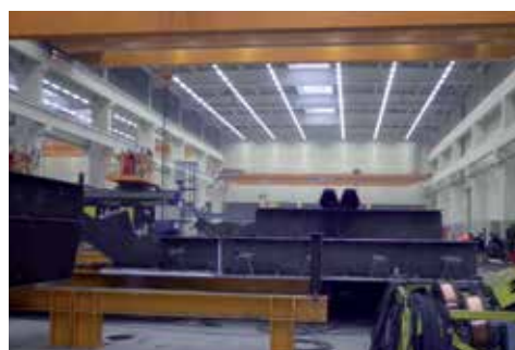
21 Vorfertigung der Bodenbleche mit Doppelquerrahmen © Max Bögl Bauunternehmung GmbH & Co. KG
