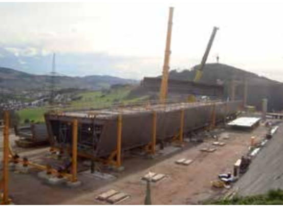
26 Vormonate von Takt 1 im Taktkeller mit Einhub der Längsträger © Max Bögl Bauunternehmung GmbH & Co. KG
