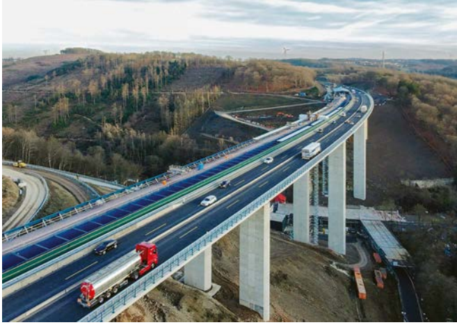
Bild 10 Fast-Track-Projekt Talbrücke Rahmede bei Lüdenscheid (A45) (Quelle: GRASSL) Fast-track project for the Rahmede Valley Bridge near Lüdenscheid (A45)
