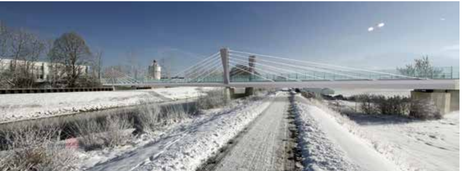
3 Komplette Querung von Renkenweg, Mangfall und Mangfallkanal © Ingenieurbüro Grassl GmbH
