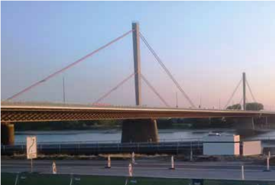
2 Bestandsbauwerk: Leverkusener Rheinbrücke © Landesbetrieb Straßenbau NRW
