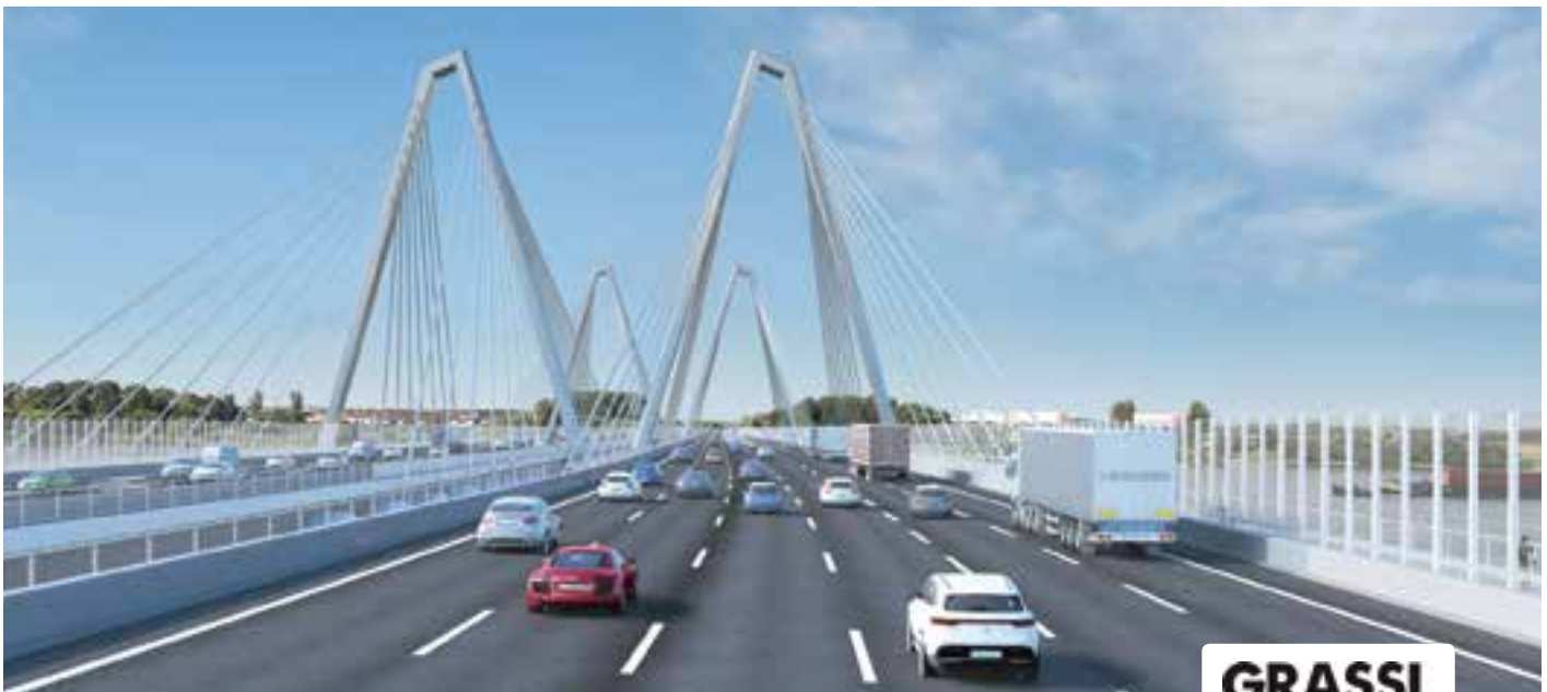
Bundesautobahn A1 | AS Köln-Niehl - AK Leverkusen-West 8-streifiger Ausbau inkl. Ersatzneubau der Rheinbrücke Leverkusen
