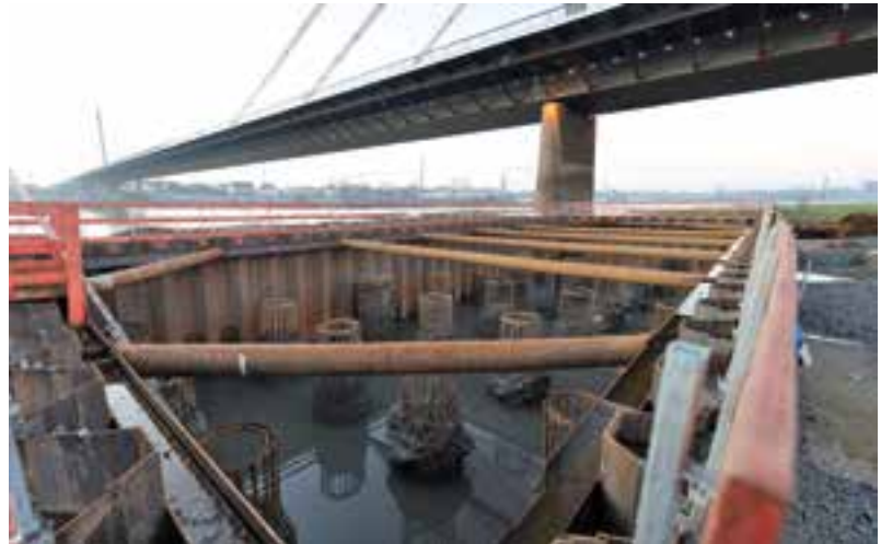
3 Ausgesteifte Baugrube in Achse 50 © Grassl Ingenieure
