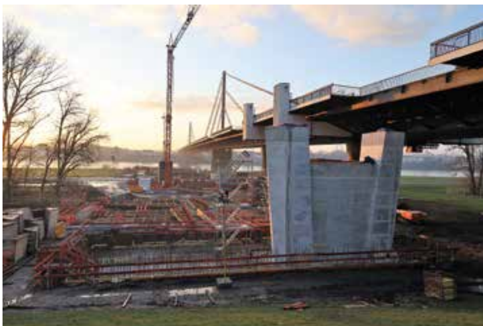
4 Baugruben der Achsen 50–80 und Kragarm entfernt am Bestandsbauwerk © Grassl Ingenieure
