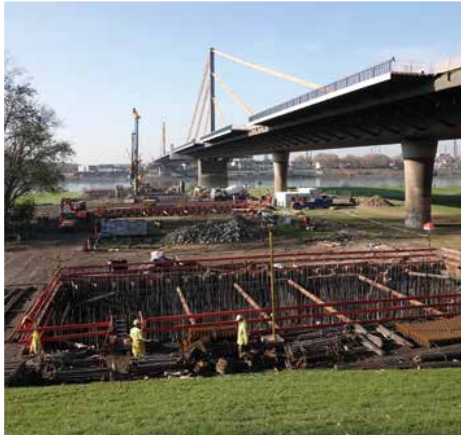
1 Baugruben und Bestandsbauwerk © Grassl Ingenieure
