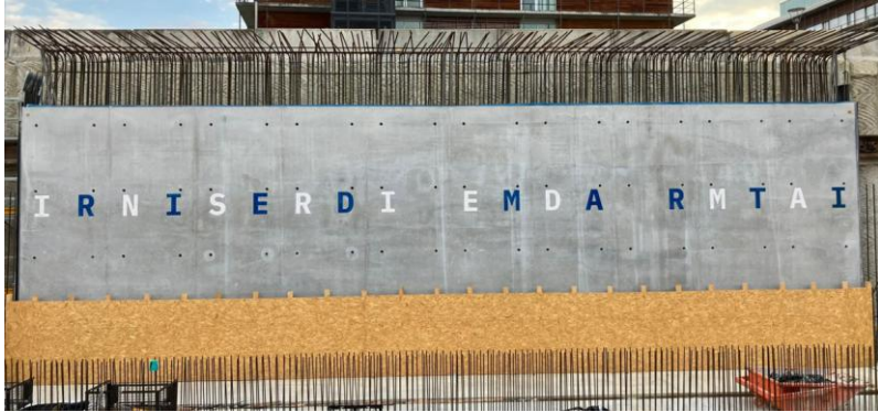
a) Ansicht einer 20m langen Wand im Stationsbereich mit Intarsien „Martinsried“
