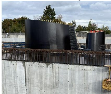
c) Schalung von zwei Öffnungen
